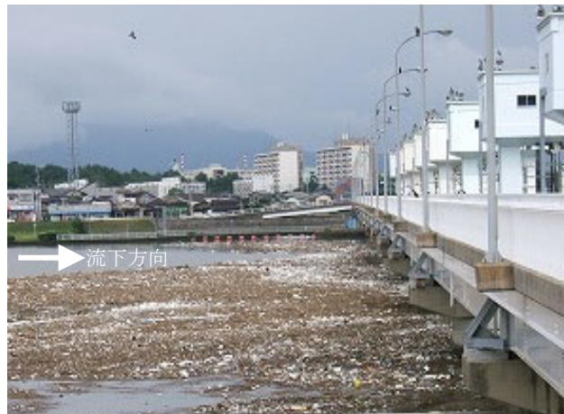
塵芥捕捉施設 設置前
