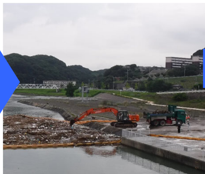
②陸揚げしトラックで運搬
