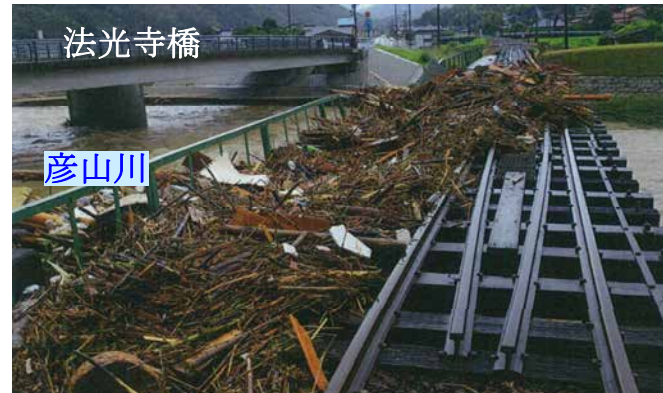
平成29年7月流木による鉄道橋被害 (彦山川26k200)
